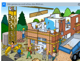
→ babelbubble: T34 Auf der Baustelle
